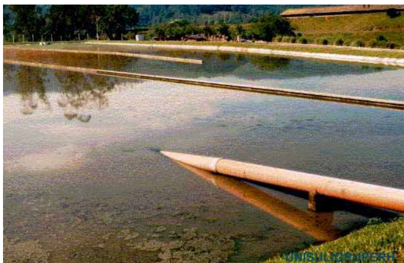
FOTO 87: Lagoa de estabilização em São Ludgero. Em destaque, a rede de esgoto cloacal.
