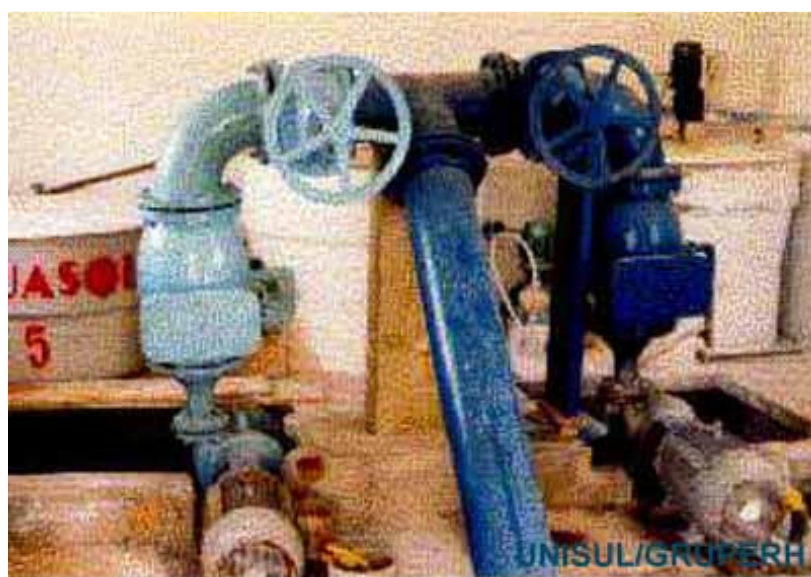
FOTO 45: Bombas encarregadas de elevar a água até o reservatório a 100 m. As duas bombas estão localizadas no interior da estação de tratamento.
