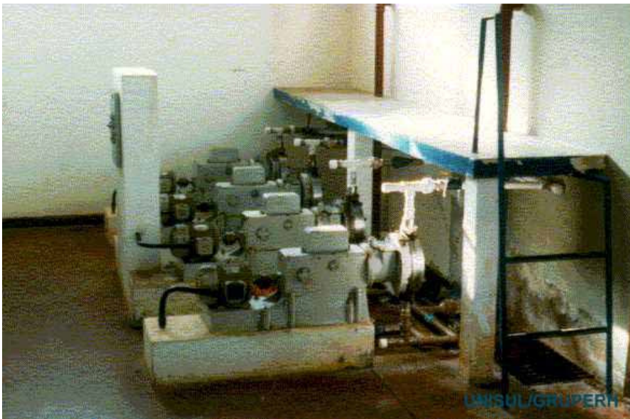
FOTO 41: Estação de tratamento de água de Imbituba. Misturadores de sulfato de alumínio. Localização em coordenadas UTM: 726366 E, 6876778 N.
