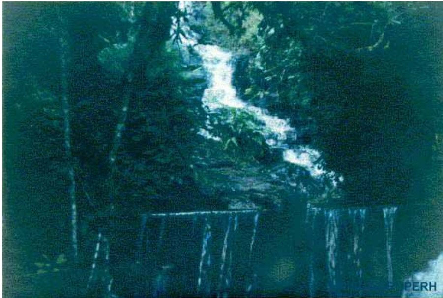
FOTO 3: Armazenamento de água para abastecimento público. Localização em Coordenadas UTM: 685379E, 6911708N
